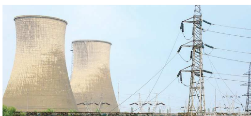
Separacja i doczyszczanie ścieków z przemysłu ciężkiego i lekkiego
